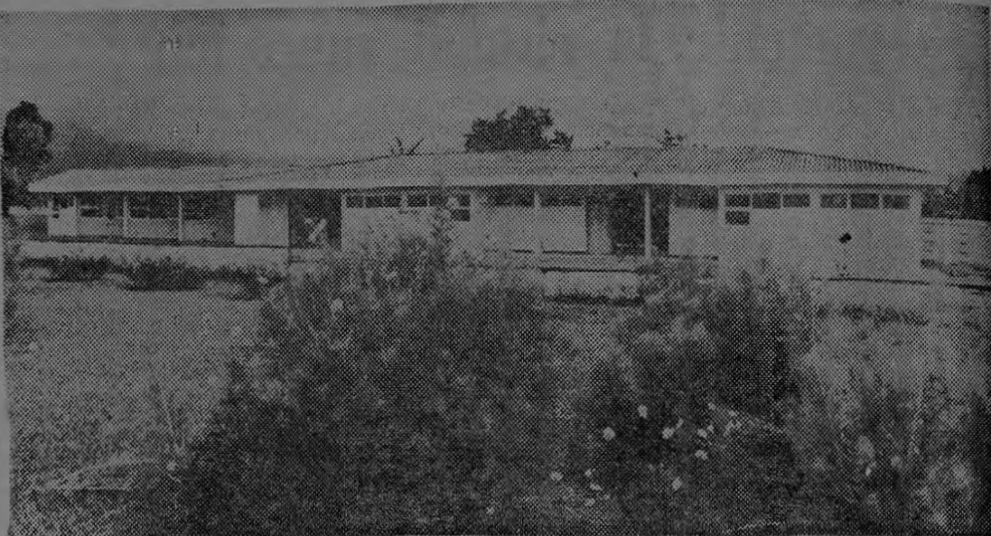
UNIDAD SANITARIA de la ciudad de San Ramón. Su actual directora es la Dra. Cecilia Mora de Arroyo. Amplio edificio, dotada de suficientes medios para prestar servicios de medicina preventiva.
